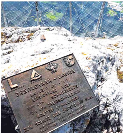
Schneenetze auf der Hohen Munde schützen seit 2014 den Teifer Ortsteil Sagl am Fuße des Bergs
