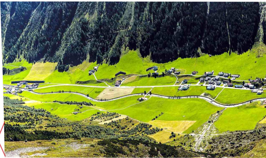
Das enge Paznauntal bei Galtür wird beidseitig von Naturgefahren bedroht. Die Siedlungen sind lokal durch Mauern geschützt
